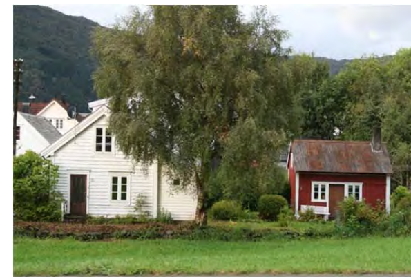
Bustad i Tverrgata, planlagt mellombygg under oppføring.. Foto: GMS
