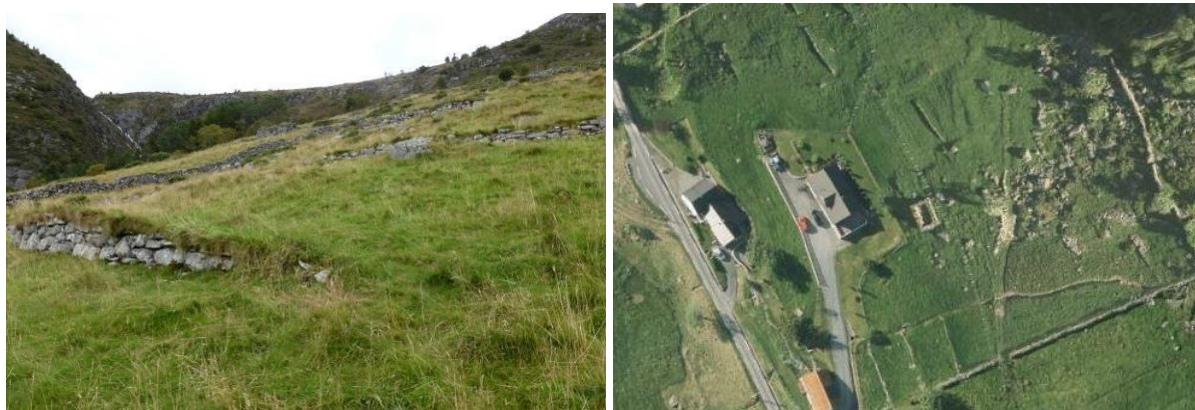
Fig. 30ab. Svært mange bakkemurer finnes i den bratte lisiden på bruk 54/3. Her har de understøttet mange små-åkre. Området beites med noe ulik intensitet. Flyfotoet som er hentet fra Fylkesatlas, dekker det meste av dette arealet og viser strukturene tydelig.
