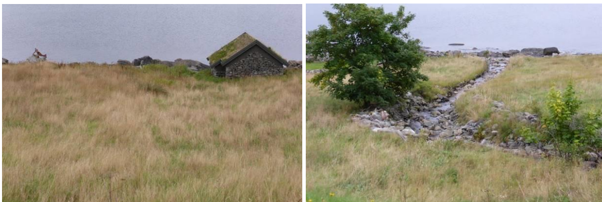
Fig. 35 Naustet på 54/4 er restaurert.
