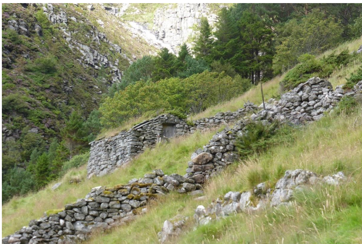
Fig. 12. I øvre del av innmarka og i tilknytning til bøgarden ligger flere gardfjøs. Murene er stort sett intakte. Oppslag av røsslyng og einer er tydelige tegn på at landskapet er i endring.
