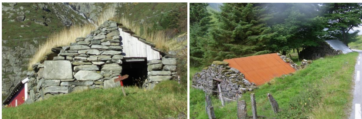
Gamle bygninger er viktige for å forstå gårdshistorien og forteller også om tidligere tiders byggeskikk. Stein var et varig byggemateriale, men takkonstruksjoner med bærebjelker av tre er utsatt. Foto tv. viser det gamle geitefjøsset på Liset 54/2, fotoet th. er et steinfjøs på Hoddevikfjellet.
