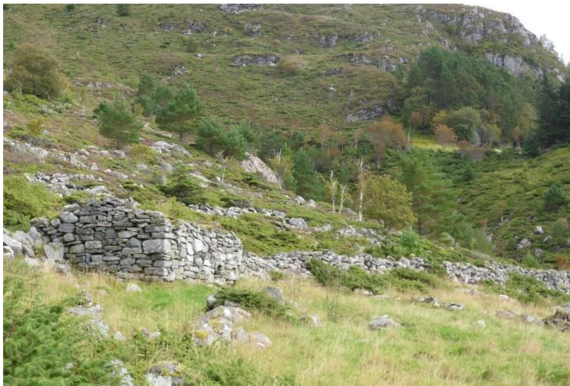
Fig. 26. Gardfjøs i bøgarden på 54/2. Både bygningsmurer og bøgard er viktige kulturminner og bør holdes ved like. Einer og lauvtre-oppslag bør ryddes vekk fra dette området.
