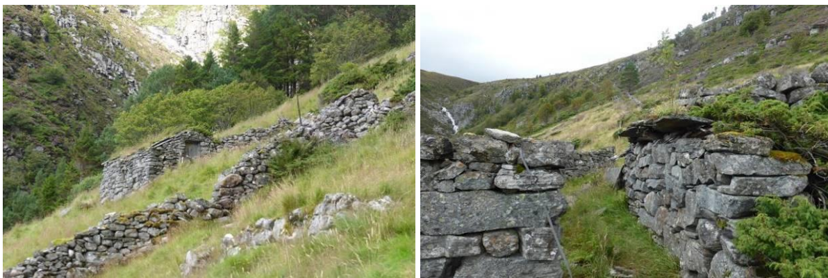
Fig. 40. Gardfjøs med tak på 54/4.
