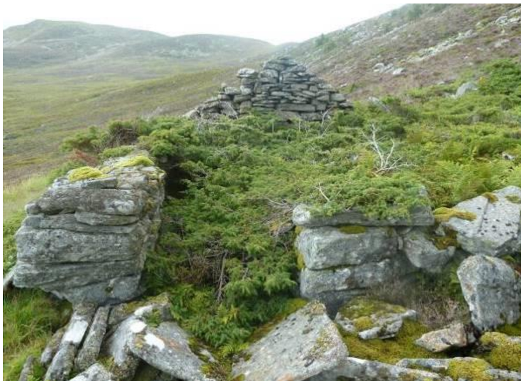
Fig. 43. Einer er en problematisk plante for de mange steinbygningene. Her har den slått seg opp inne i et gammelt steinfjøs til 54/2. Foto: Halvor Hammersvik.
