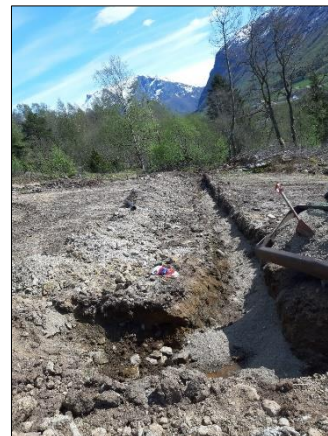
Avskjeringsgrøft. Foto: Bernt Reed, Gloppen kommune.
