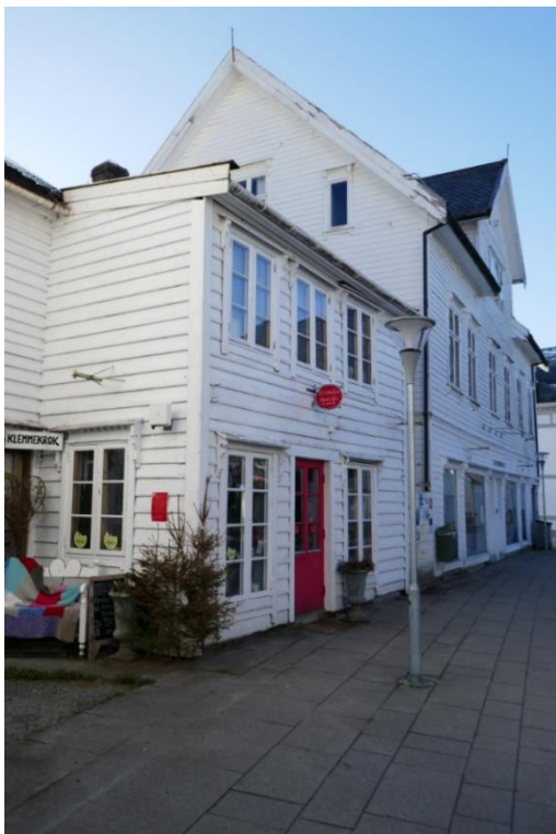
Bilde 5: Bygg i Eidsgata. Foto: Norconsult
