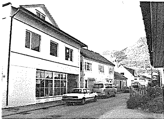
I nordenden av Gata er fleire mindre bustadhus. Ei truleg velmeint ombygning av eit 60-tals betonghus, med gjennomgåande vindaugsband er blitt til ei forvirring av stilartar, diverse vindaugstypar og borddekorasjon for å falle inn i «Gatestilen».
