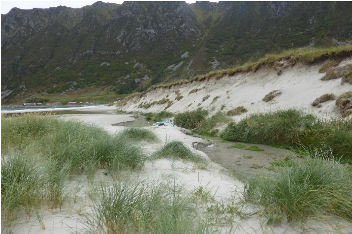
Fig. 14. Dynefronten ved 46/14 er høy og ustabil med vegetasjon som henger utover kanten hvor deler av denne stadig faller ned. Elveløpet som følger skråningen i nedkant gjør stabilisering av dynefronten vanskelig.
