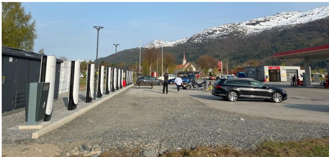
Figur 22: Den nye el-ladestasjonen framfor Circle K ligg på same område som det tidlegare stod ei trerekke. Foto av Norconsult, mai 2024.
