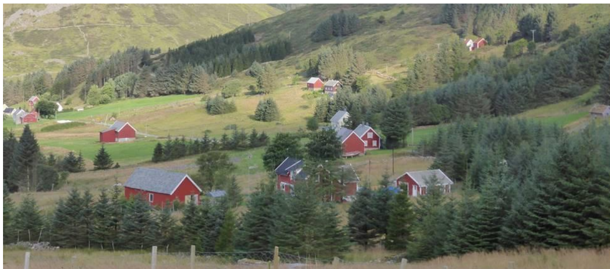
Fig. 23. Dragebygd i 2014 sett fra øst. Sitkagranplantingene er omfattende, men landskapet er likevel oversiktlig. I framgrunnen er bygningene på 250/8 og 250/7 godt synlige fra Drageidvegen før man kjører ned til bygda. Denne utsikten er sterkt redusert i dag og gårdstunene er knapt synlige.
