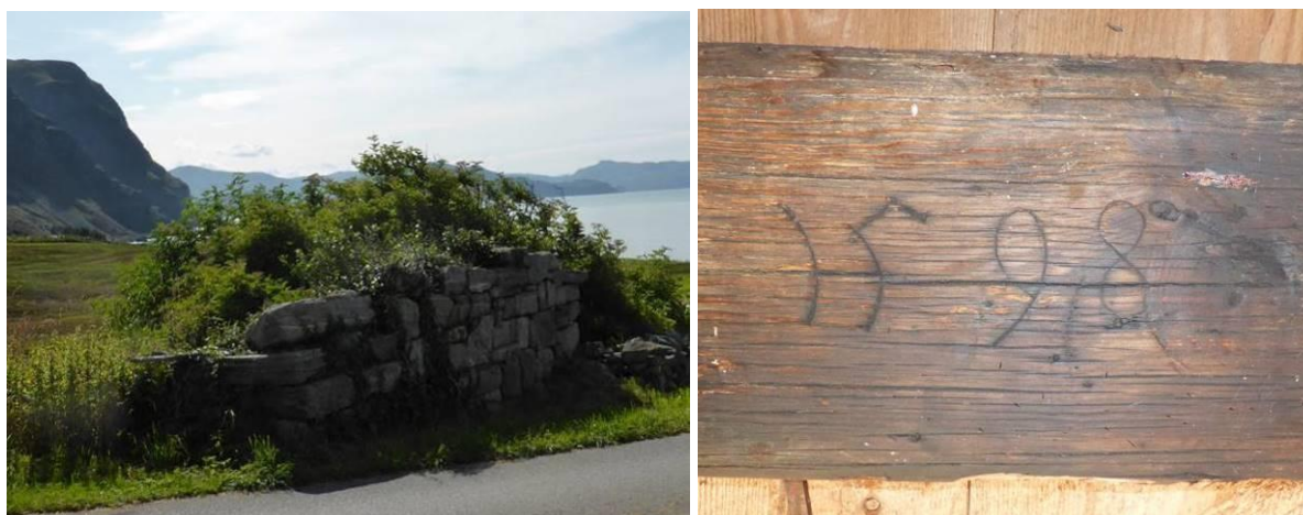
Fig. 15. Det er bevart lite av bygningene i det gamle klyngetunet, Murer etter et eldhus på 250/1 er tatt vare på, men mye stein har blitt fjernet i årenes løp. Fig.16. Fjøset og låven på 250/1 har blitt bygget på i flere omganger. I deler av bygningen finnes også tømmer fra andre og eldre bygninger, trolig også fra årestuen som sto i det gamle klyngetunet (bygning nr. 251). I fjøsbygningen var det tidligere også et gårdsmeieri.
