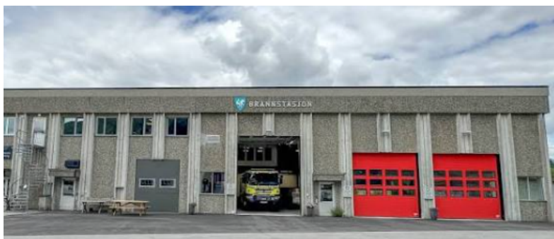
Fasade etter ombygging
